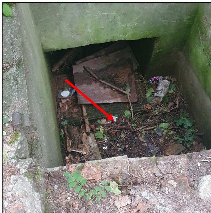
Foto 12: Pohled na žumpu vedle vstupu do třetí části z J strany, dole shozený kovový poklop s rámem
