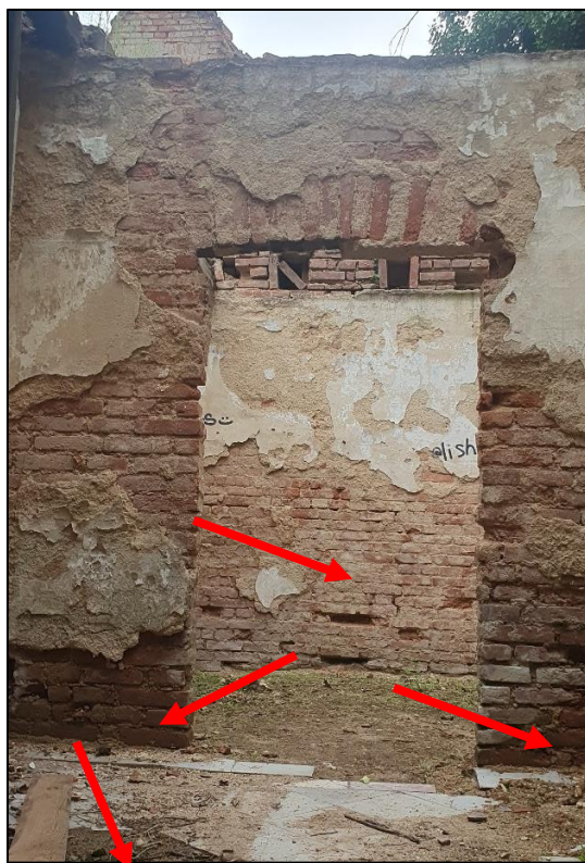
Foto 9: Průhled dveřním otvorem do druhé místnosti této části, zdevastované zdivo příčky, zadní zdi i dlažba podlahy
