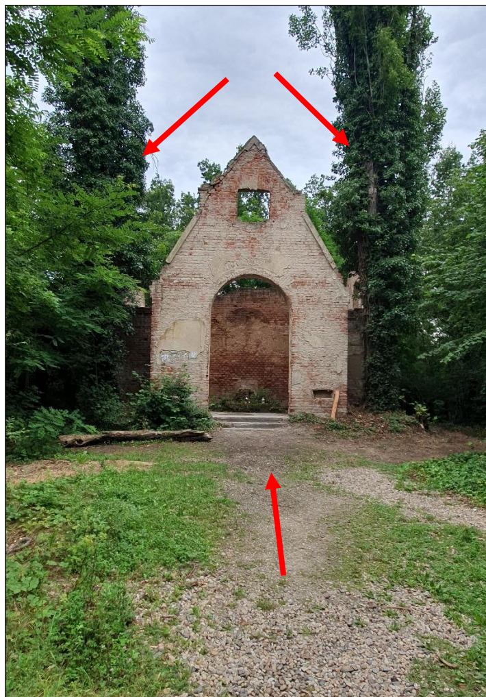
Foto 1: Pohled na portál kaple od S z přístupové cesty, zřetelně porušeném zdivo štítu vlevo vedle okna, mohutné topoly těsně po obou stranách stavby
