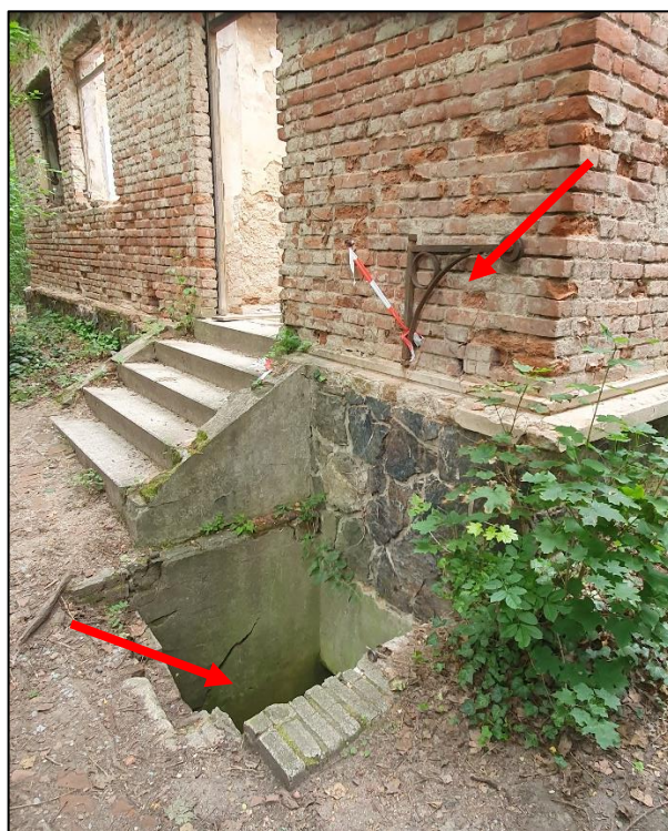
Foto 8: Bližší pohled na JV nároží, J vstup se schodištěm, žumpou a otočným ramenem s kladkou nad ní
