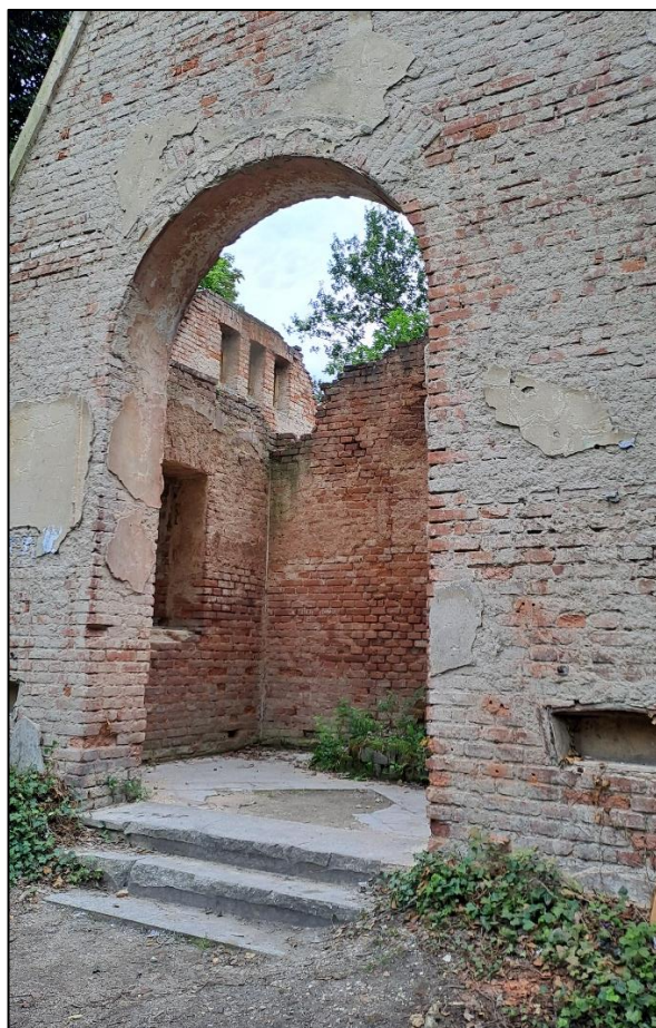
Foto 3: Bližší pohled hlavním vstupem kaple, zdevastované cihelné zdivo se zbytky omítek, žulové schodiště a porušení podlaha s betonovou dlažbou
