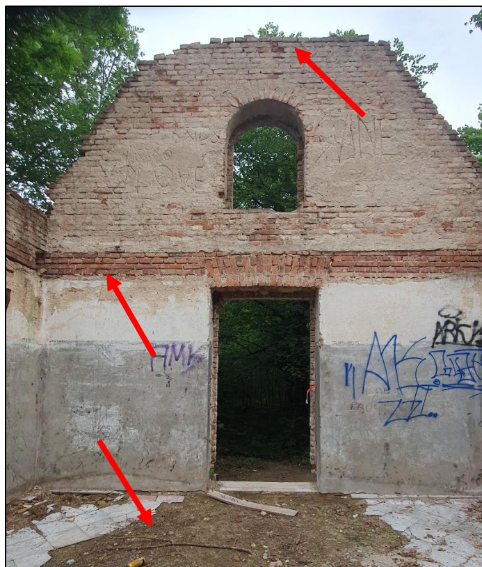
Foto 5: Bližší pohled z vnitřní strany na Z štít, zdevastované zdivo i podlaha, viditelný pás po původní dřevěné stropní konstrukci
