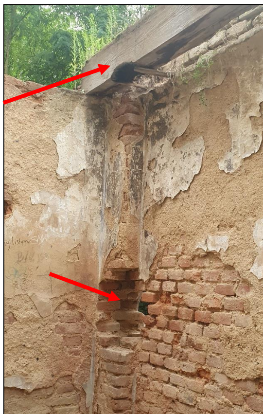
Foto 10: Bližší pohled na nároží komínu v zadní místnosti (styk příčky a střední zdi), nahore zbytky stropního trámu
