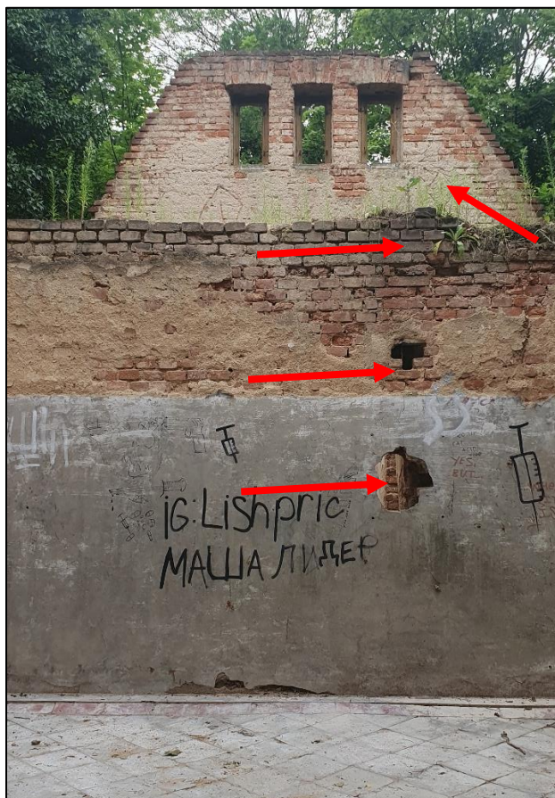
Foto 7: Pohled na vnitřní nosnou stěnu k V, se zbytky komínového tělesa, v pozadí V štít sousední části
