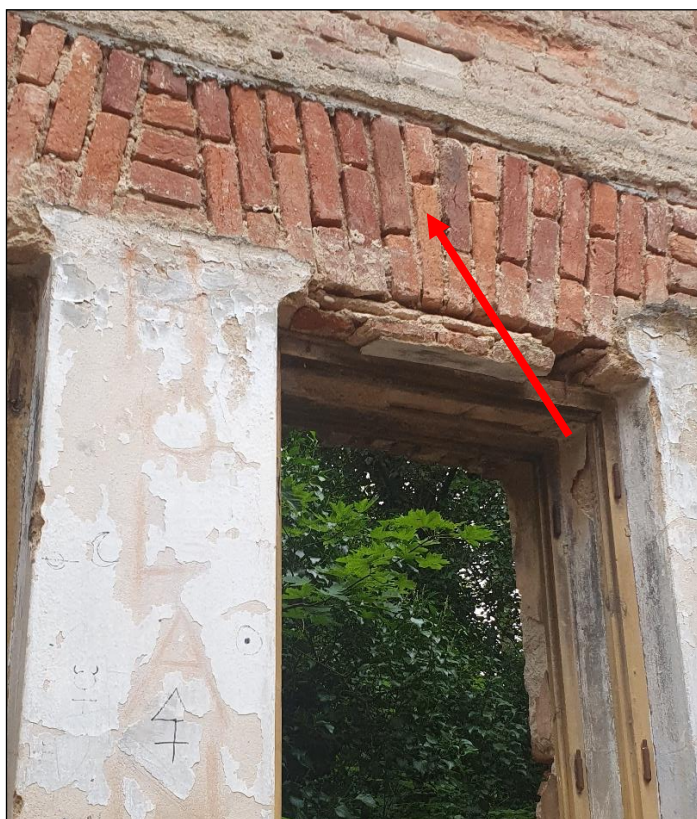
Foto 11: Příklad ploché klenby nadpraží oken, obdobné provedení i u nadpraží dveřních otvorů
