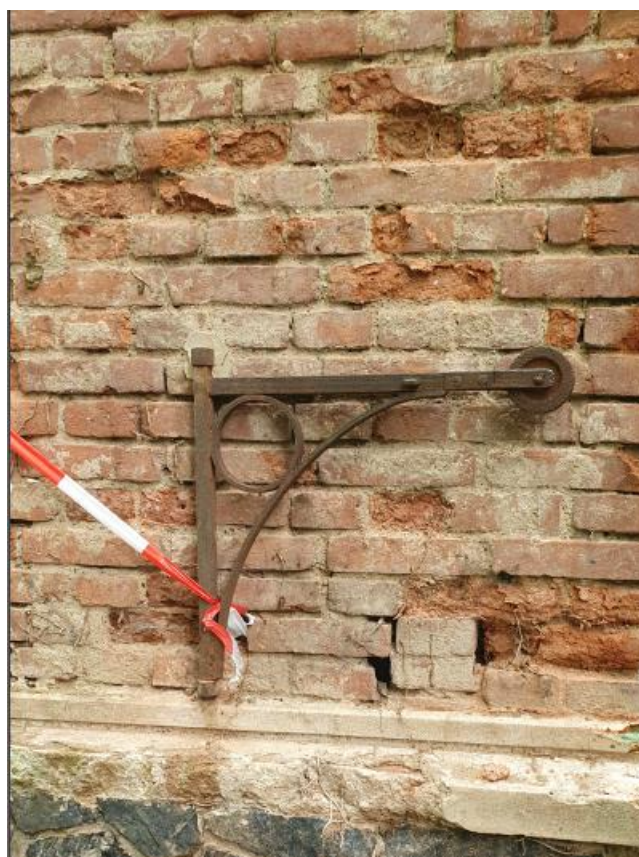
Foto 16: Viditelný rozpad některých cihel v obvodovém zdivu nad žumpou
